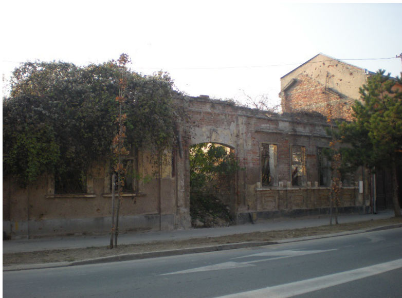
Figure 45 : Maison en ruine dans le centre de Vukovar. Cliché de l'auteur (17/11/2011)
