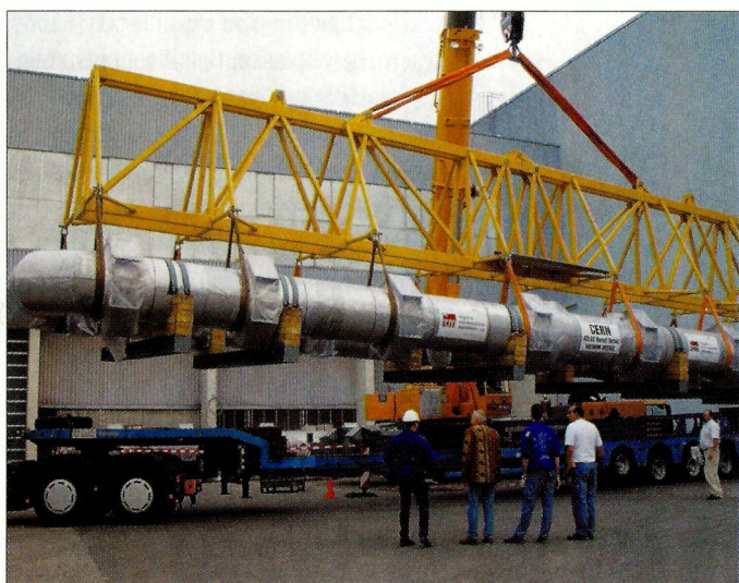
La compagnie espagnole Felguera Construcciones Mecánicas SA a construit des enceintes à vide de 25 m de longueur pour le tore supraconducteur (partie tonneau) d'ATLAS. On voit l'arrivée au CERN d'une de ces enceintes. (Photo: P Collins.)
