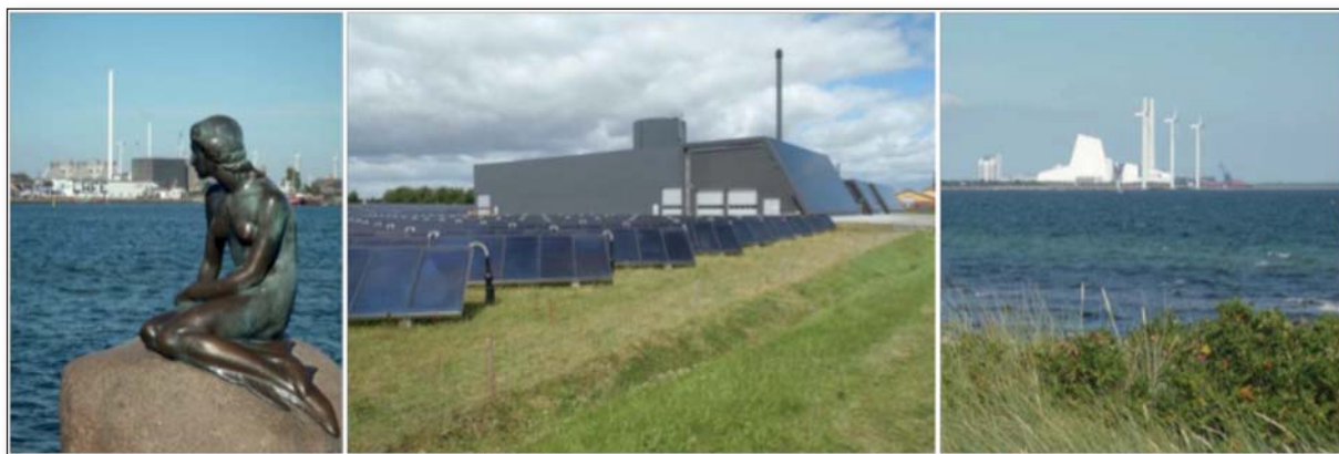
Fig. 16 : Centrales de cogénération charbon (à gauche) et biomasse (à droite) à Copenhague ; unité locale de cogénération et chauffage urbain solaire-biomasse à Gråsten (au centre)
