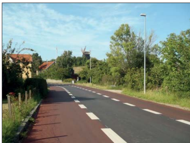
Fig. 27 : marquage au sol des rues à Brundby (Samsø, 2015)
